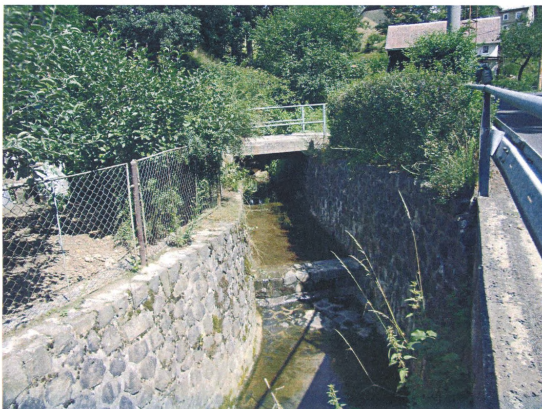
Foto č. 10 Stupeň a lávka, ř. km 2,32 (proti proudu)
