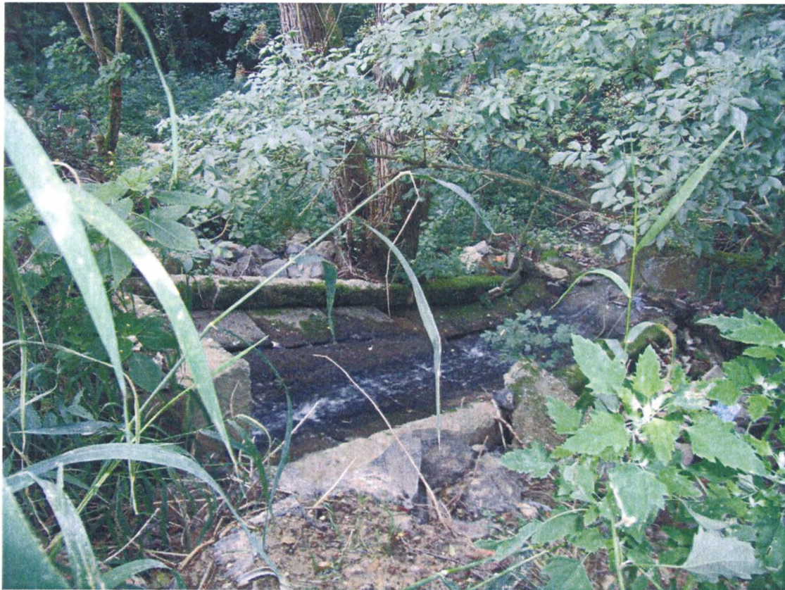
Foto č. 29 Odpad bezpečnostního přelivu rybníka
