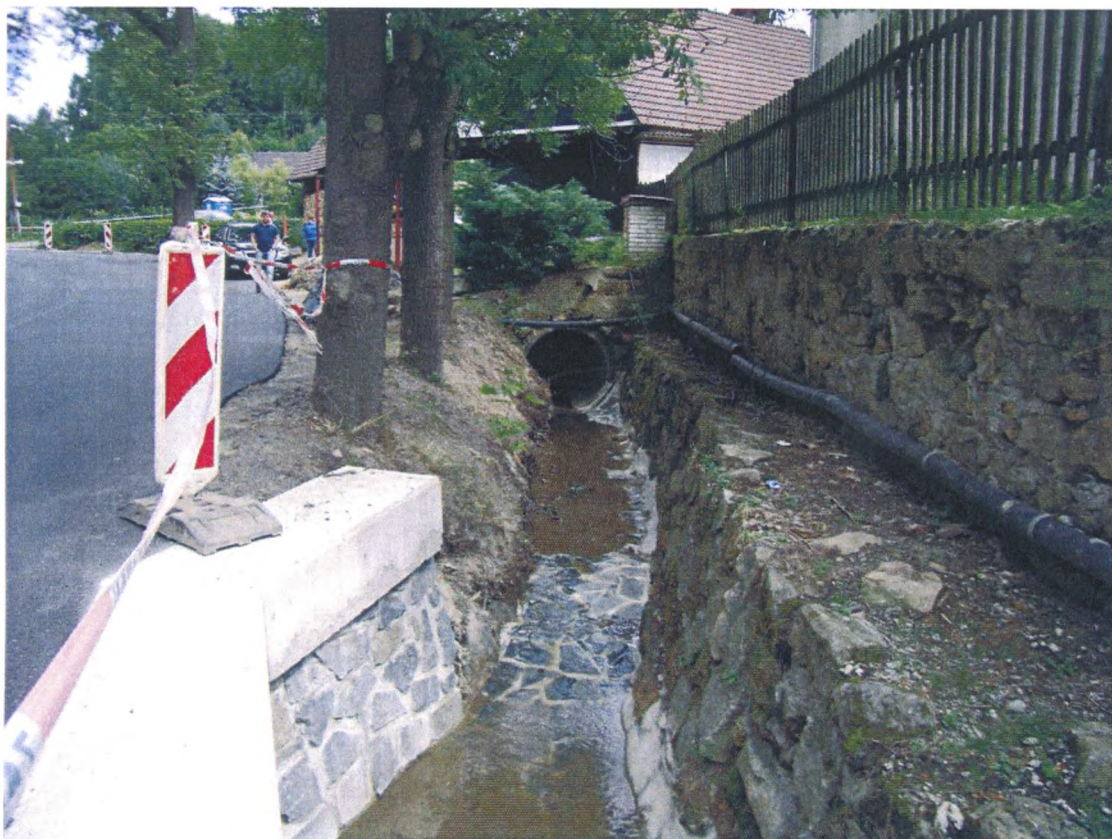
Foto č. 17 Propustek, ř. km 3,11 (proti proudu)
