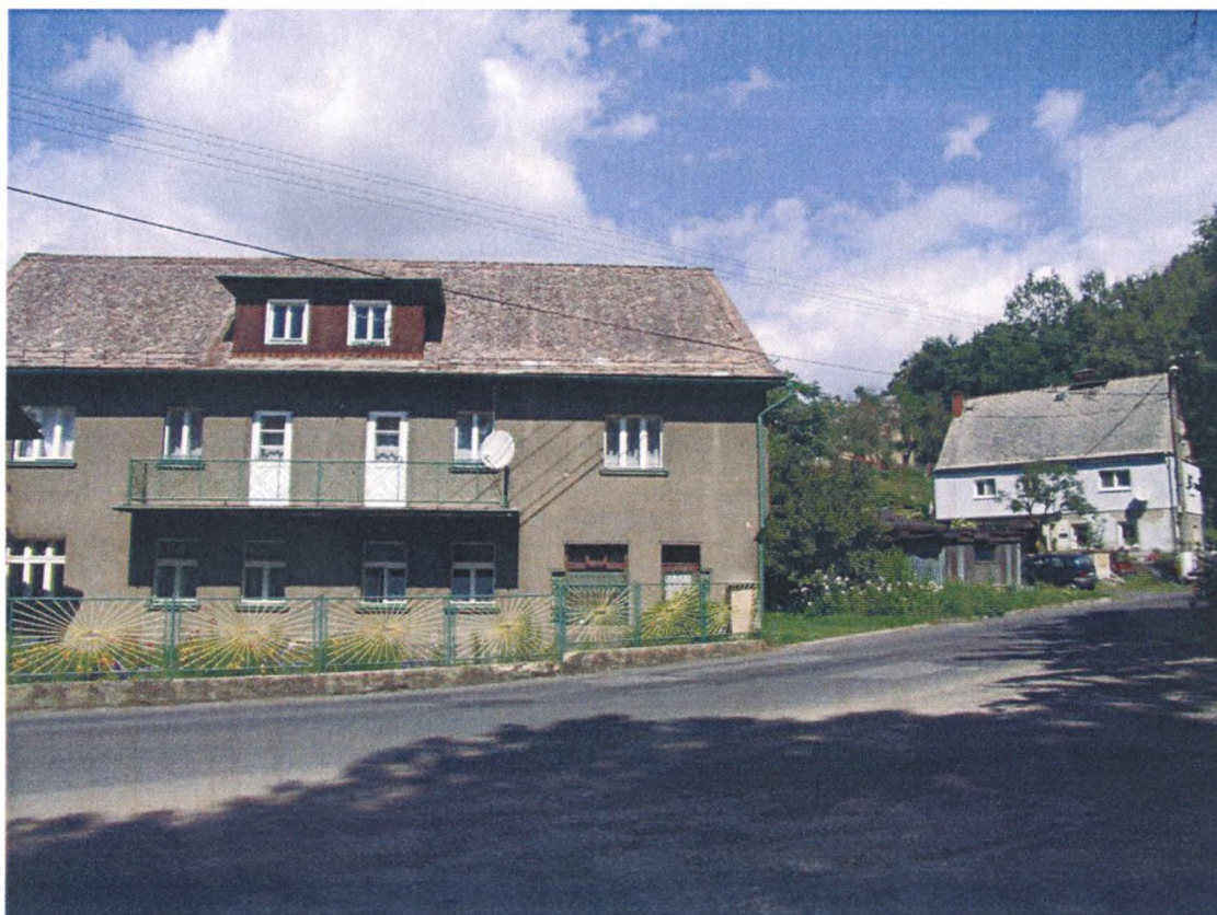
Foto č. 8 Ohrožené nemovitosti v místě soutoku Ludvíkovického a Loubského potoka (č.p. 84 a č.p. 87)
