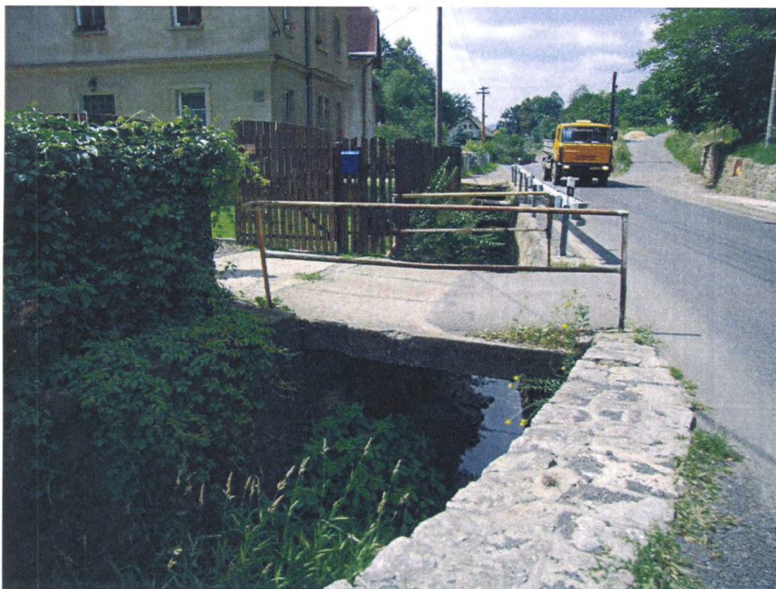
Foto č. 13 Mostek k č.p. 51, ř. km 2,87 (po proudu)
