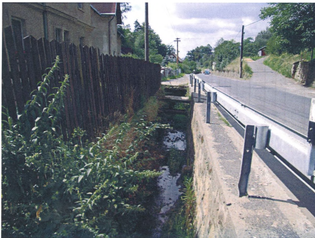
Foto č. 12 Lávka a potrubí v průřezném profilu koryta, vtok do uzavřeného profilu, ř. km 2,85 (po proudu)
