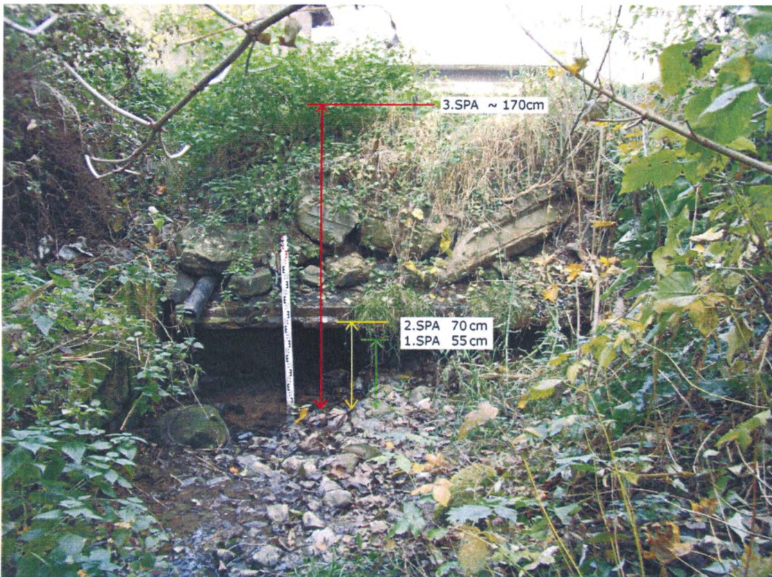
Foto č. 30 Hlásný profil na Loubském potoce – vtok do propustku v ř.km 0,01 (naproti čp.84)
