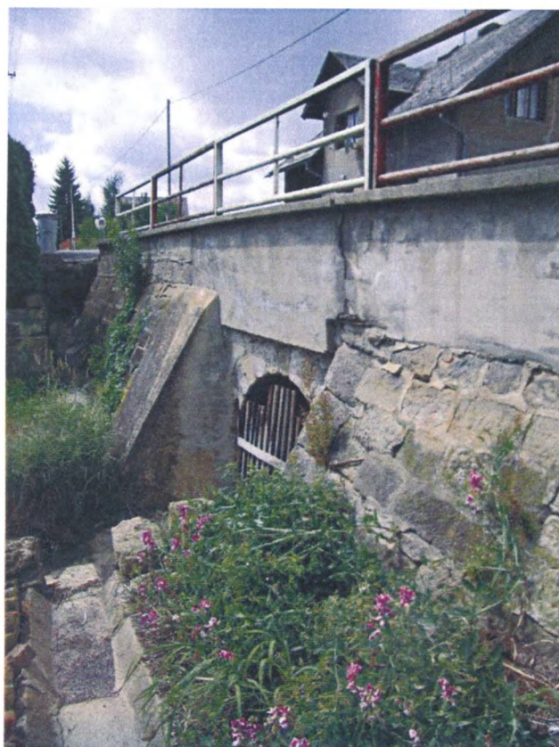
Foto č. 26 Silniční most ř. km 4,06 (proti proudu), zahrazený výtok dřevěným plotem
