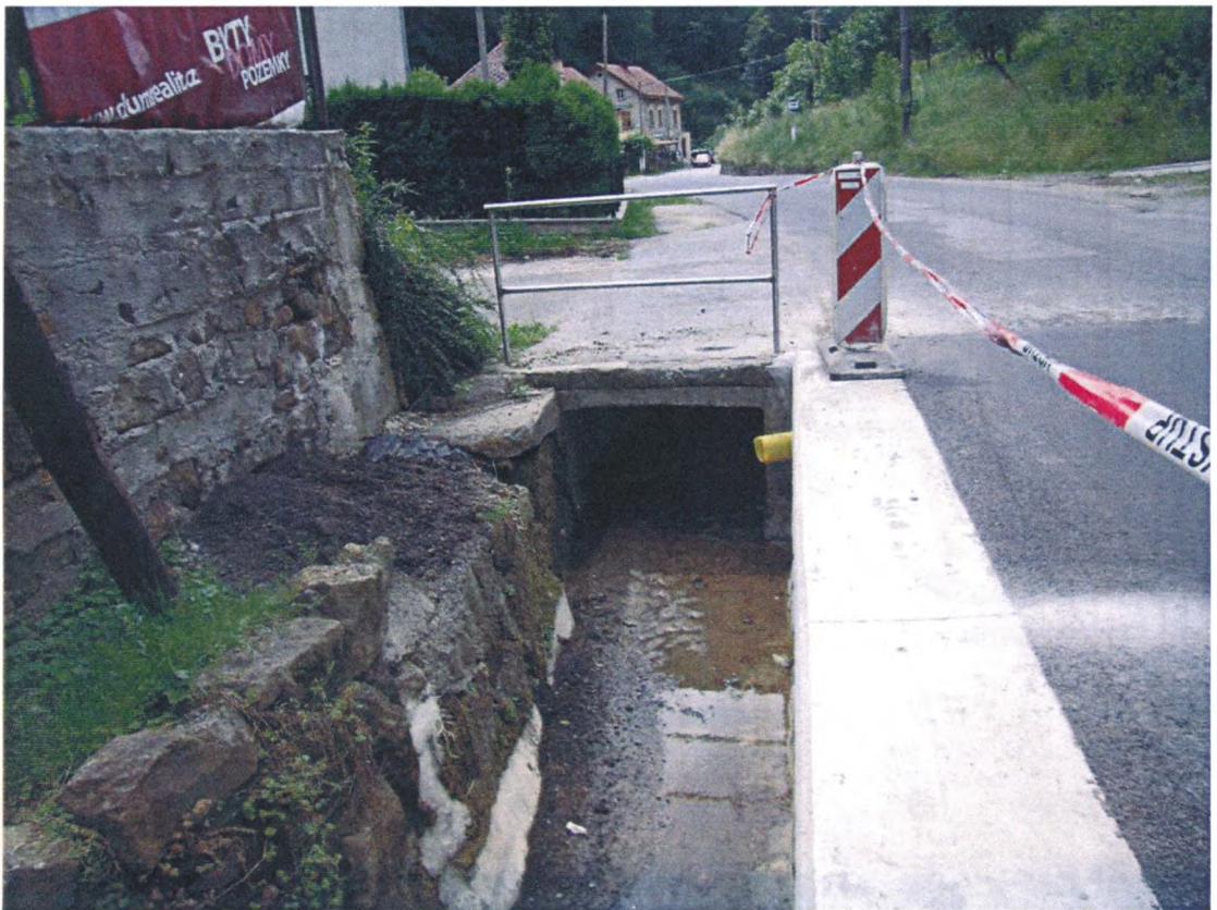
Foto č. 16 Vtok do uzavřeného profilu ř. km 3,08 (po proudu)
