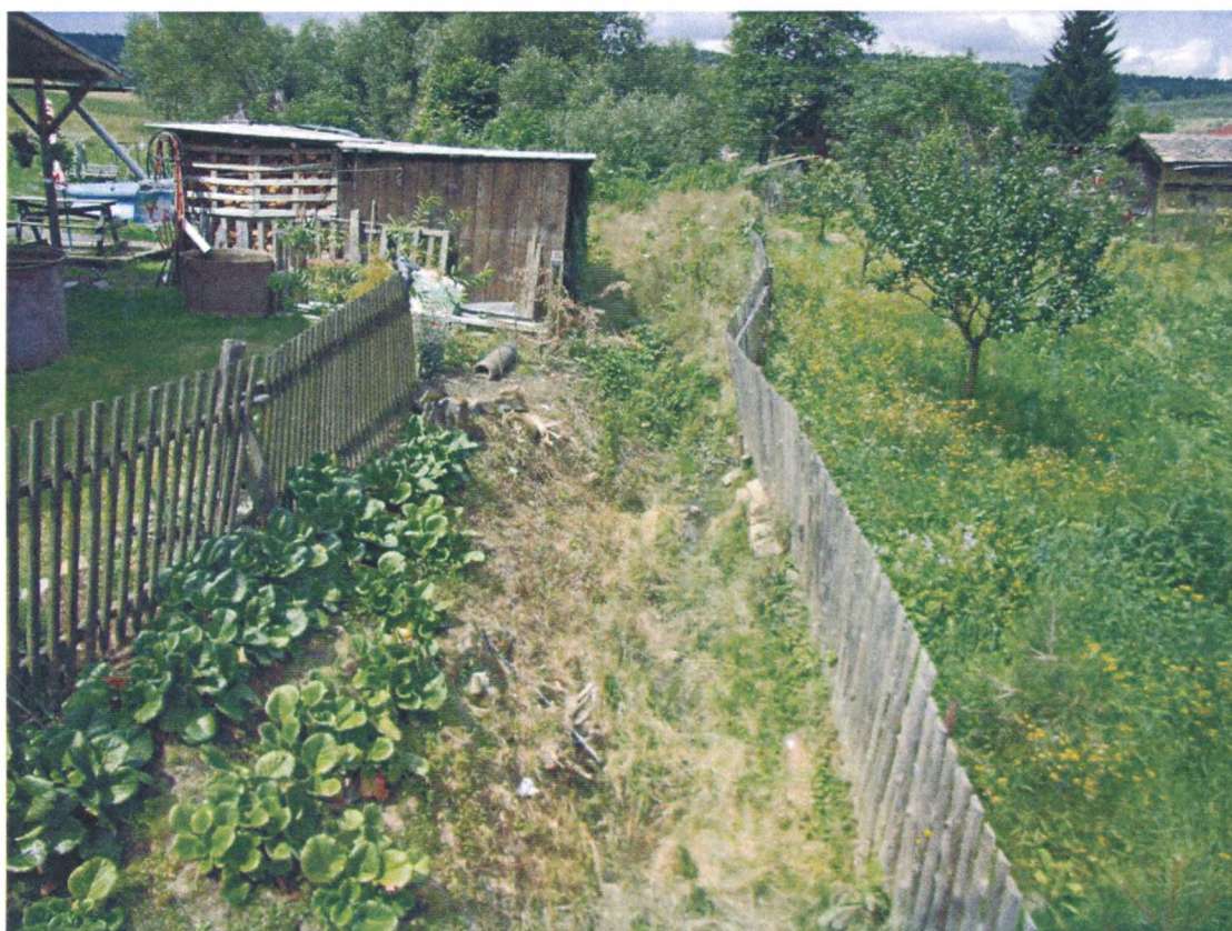
Foto č. 24 Koryto Ludvíkovického potoka u č.p. 120, ř. km 4,07 (proti proudu)
