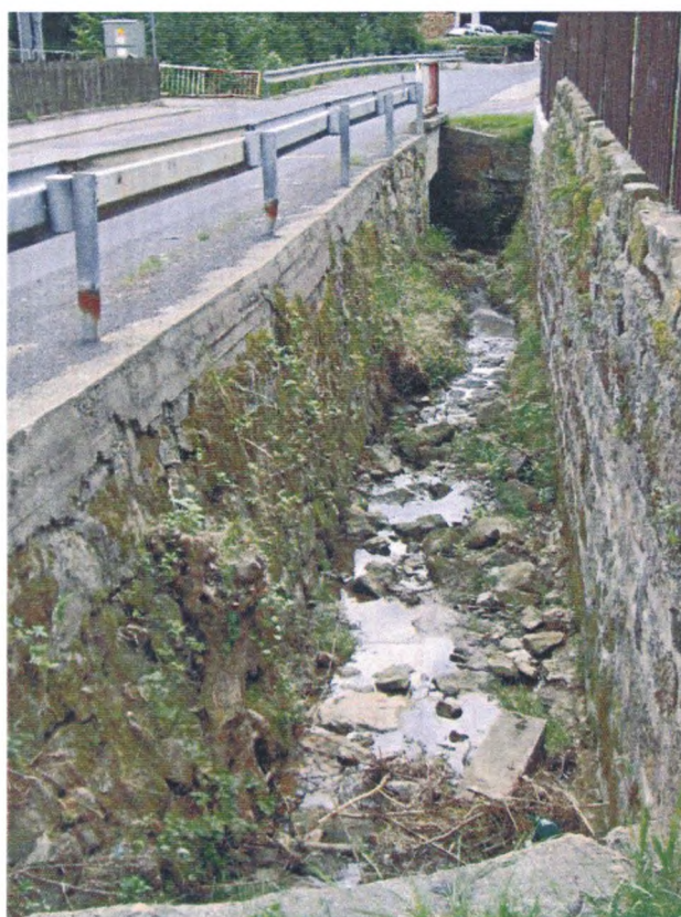
Foto č. 20 Silniční most ř. km 3,21 (po proudu)
