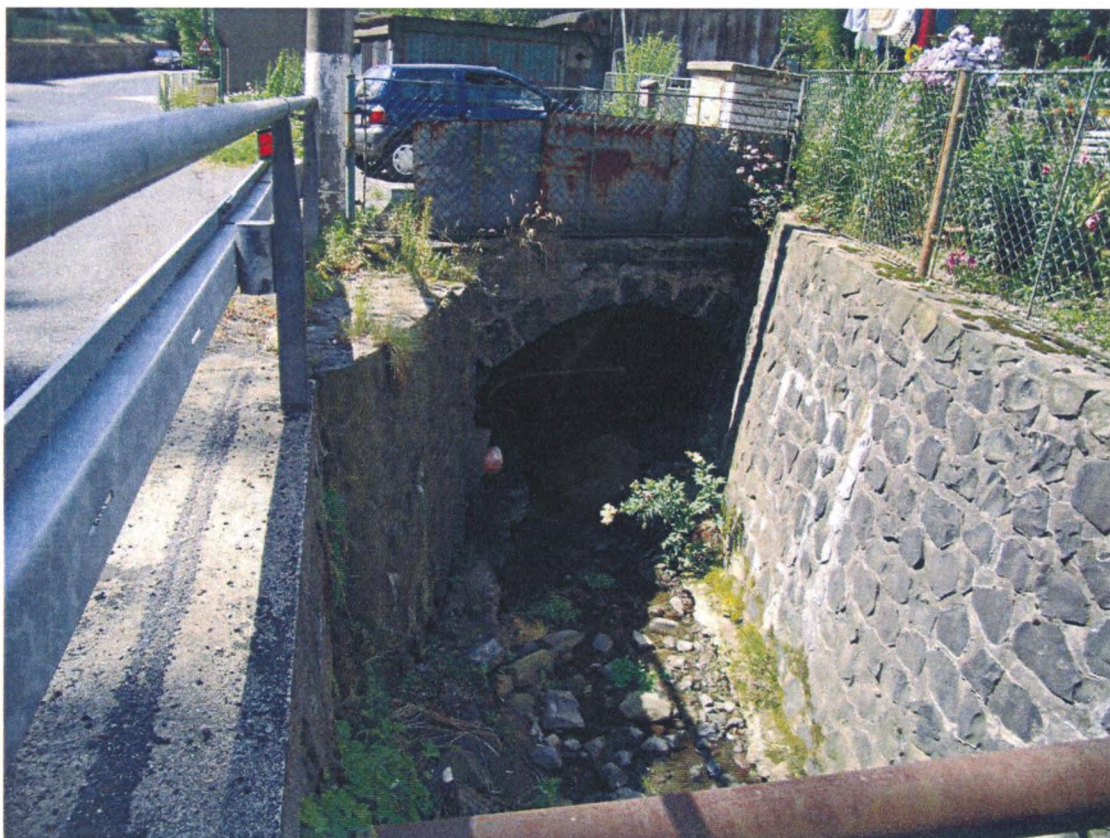
Foto č. 9 Vtok do uzavřeného profilu, ř. km 2,28 (po proudu)
