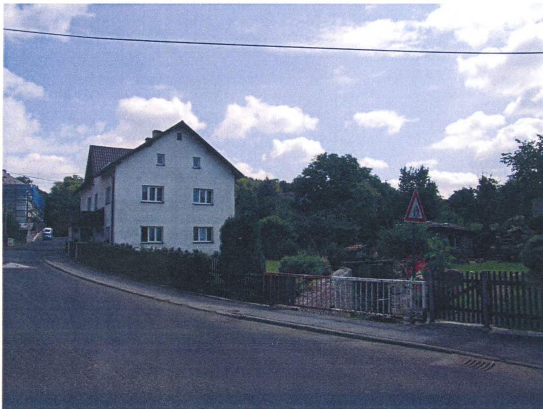
Foto č. 4 Koryto před vtokem pod silniční most, ř. km 2,07, ohrožená nemovitost č.p. 72 (proti proudu)
