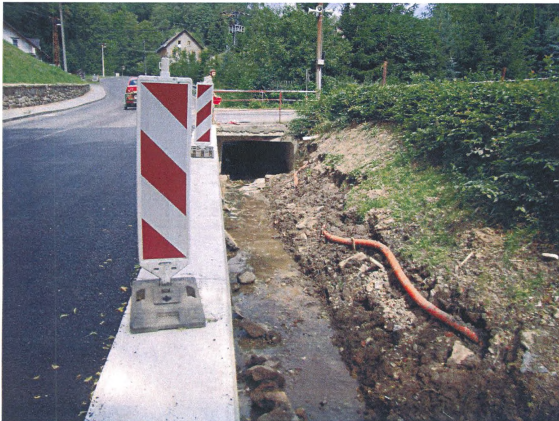
Foto č. 18 Propustek ř. km 3,15 (proti proudu)
